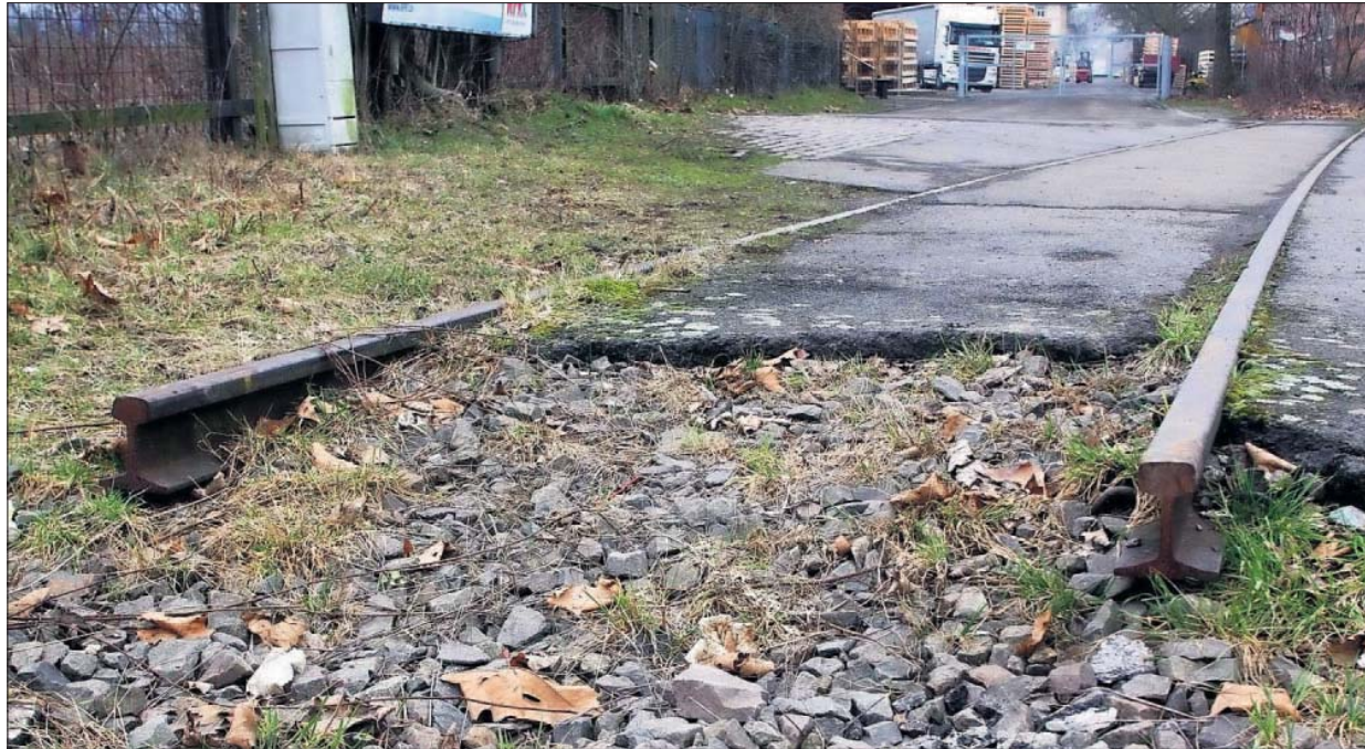
Unterbrochene Bahnleise in Höhe des ehemaligen Bubenhauser Bahnübergangs.
